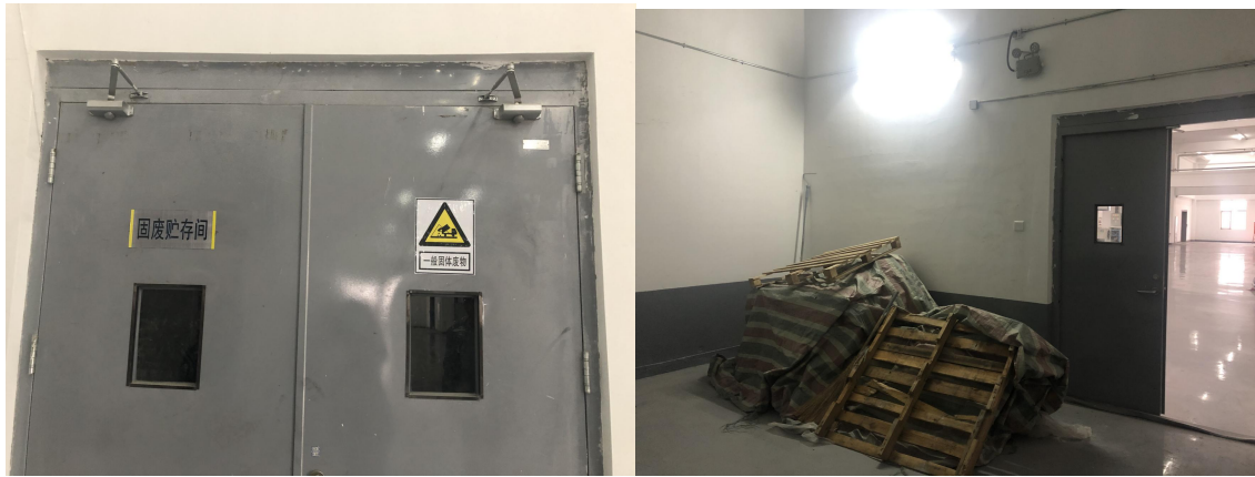
图 4-3 一般固废暂存间
